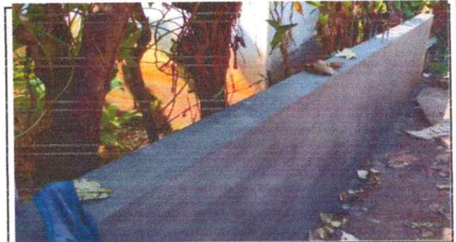
FOTO 6: Reparacion muros interiores (MODULO AULA II)
